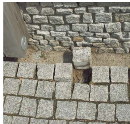
Kostka wokół widowni została położona zbyt płytko
