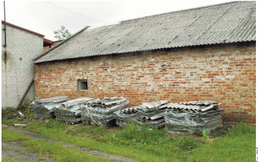
Na terenie naszej gminy na dachach budynków zalega ponad 2 mln kg płyt zawierających azbest
