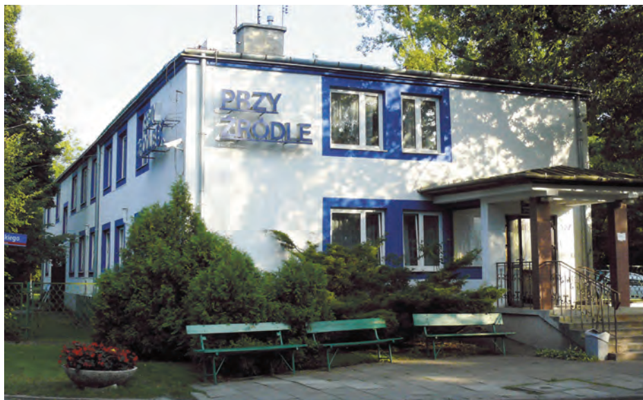
W miejscu obecnego sanatorium Przy Źródle ma powstać Centrum Fitness i Hydroterapii
