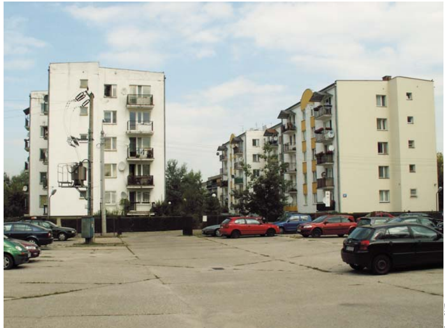
Ciepłą wodę i ogrzewanie mieszkańcom mirkowskich bloków powinna zapewnić gmina, która do tej pory nie podjęła żadnych działań w tym kierunku
